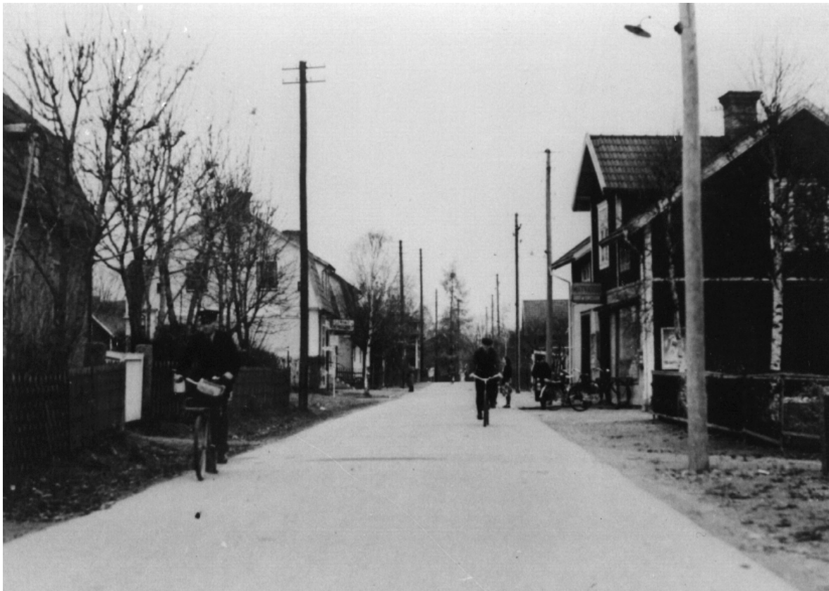
Siljansvägen (Storgatan) mot norr 1943 nära Lamellgatan.
