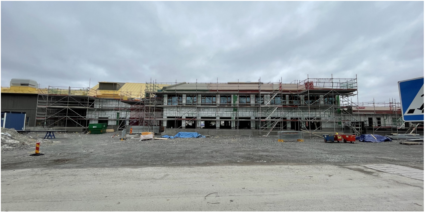
Bilden ovan visar byggnad 1 och taket som nu är på plats, till vänster i bild har även plåtslagaren startat
