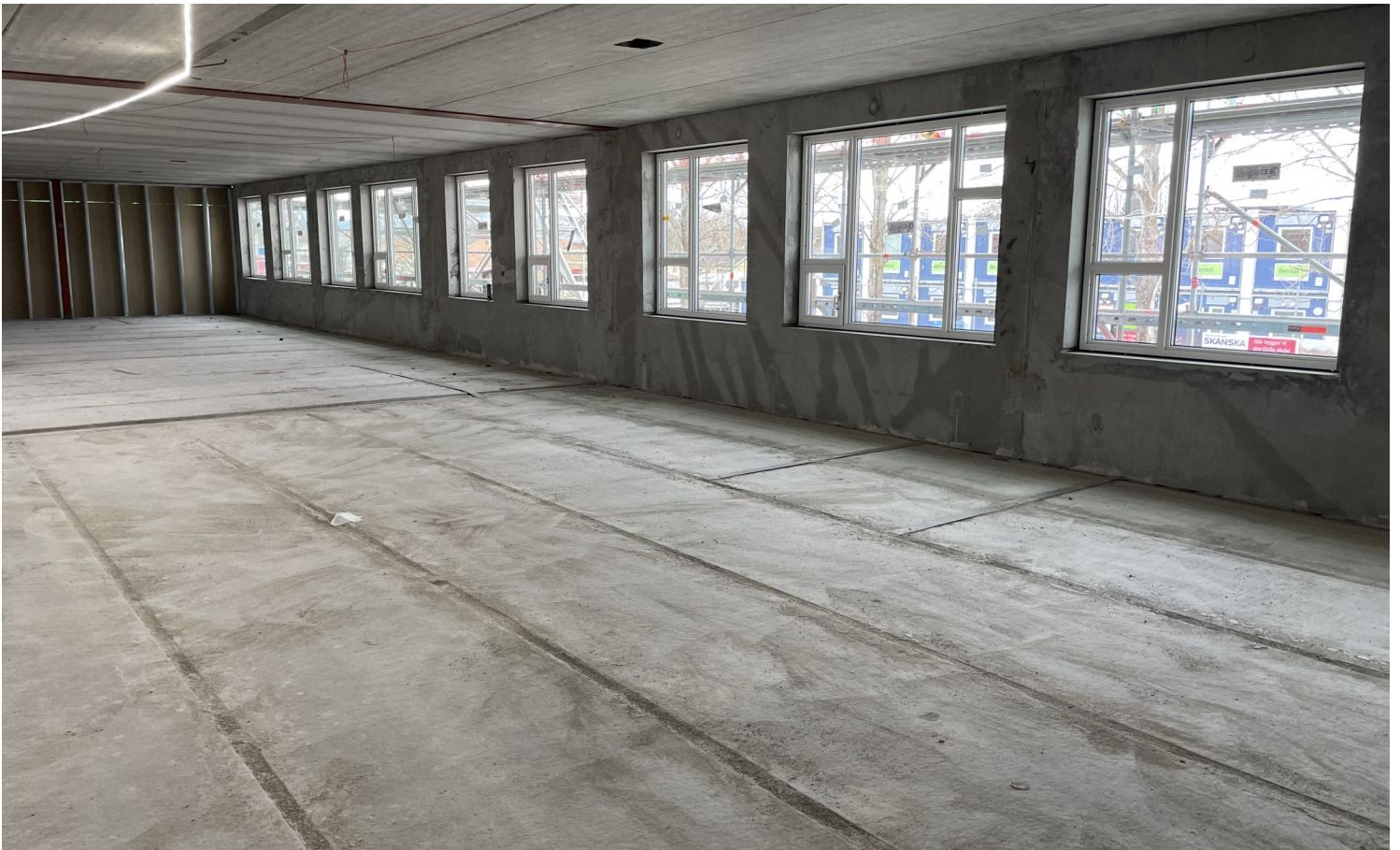
Bilden ovan visar plan 2 där vi börjat få i fönster, Byggnad 1.
