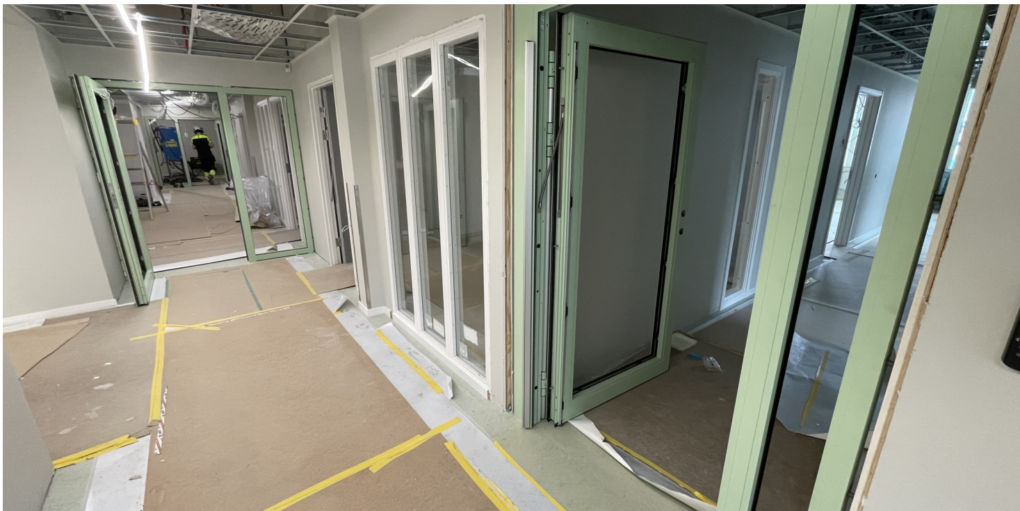
Bilden ovan visar invändiga glaspartier som nu är på plats, Byggnad 3.
