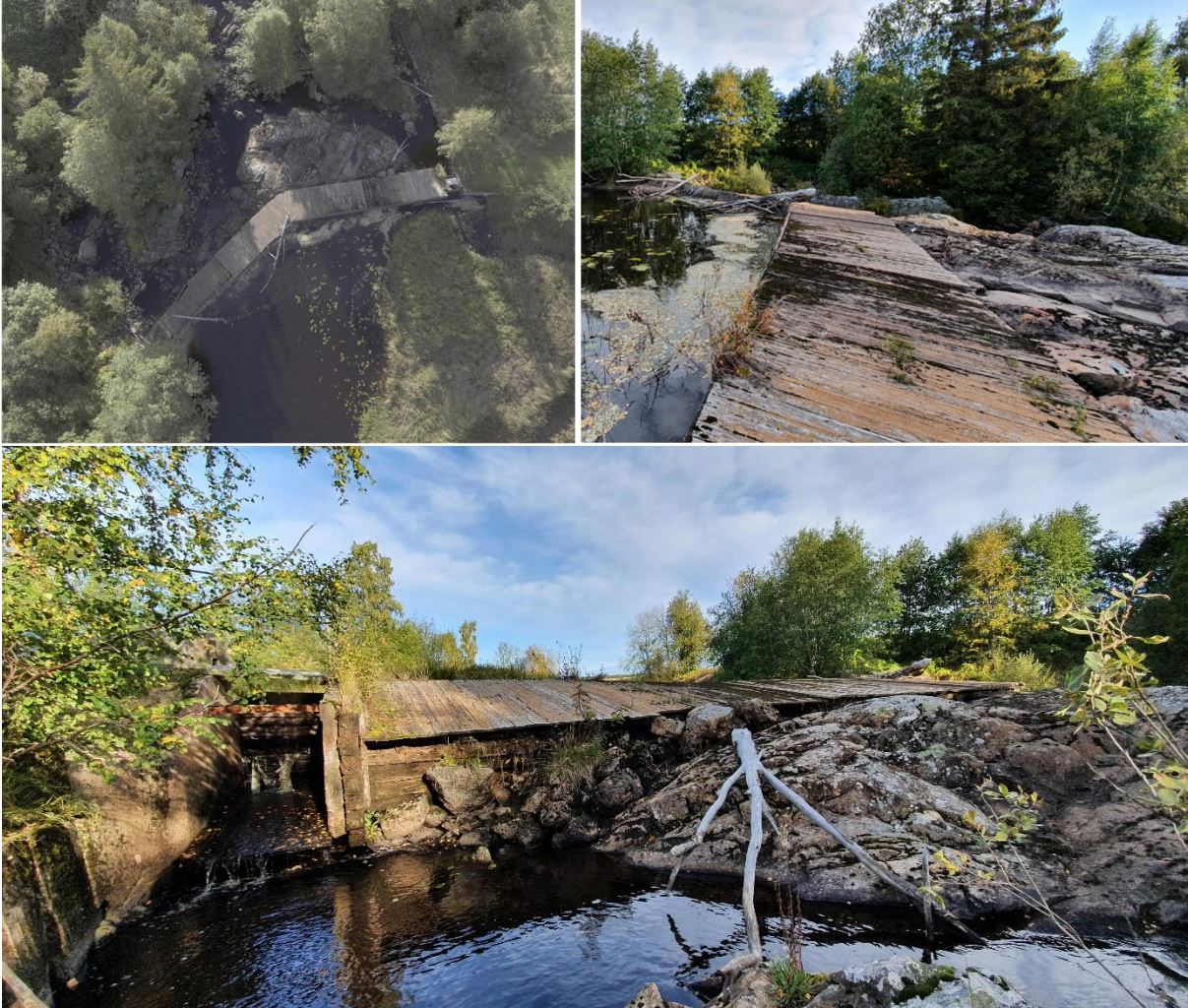
Damm vid tidigare fiskodling i Spraxkya
