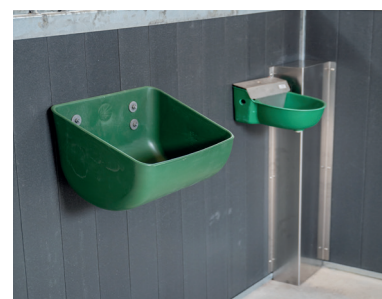
I bilden syns gnagskydden av plåt till vattenrören
