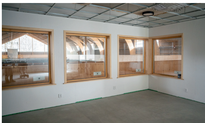
Cafeterian börjar bli färdig. Undertaket ska snart på plats.
