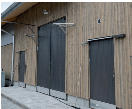
Detaljer kring portarna är på plats, samt belysning.
