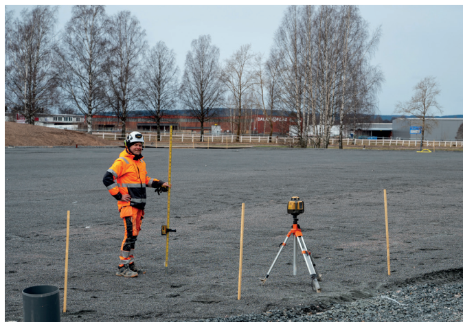
Markarbeten pågår kring hela anläggningen. Här förbereds för den stora ridbanan.
