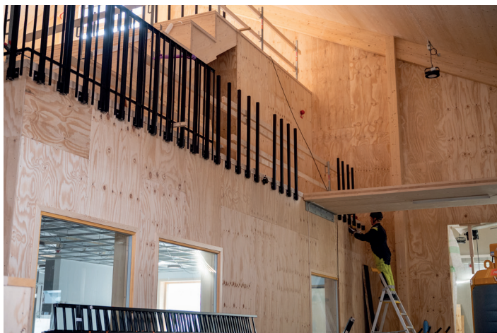
Läktaren i ridhus 1 får staket. Framtill mot ridhuset blir det glas. Även bron över till "stallingången" ska få räcken.
