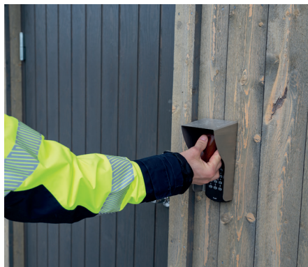
Passagesystem är installerat till stallet.
