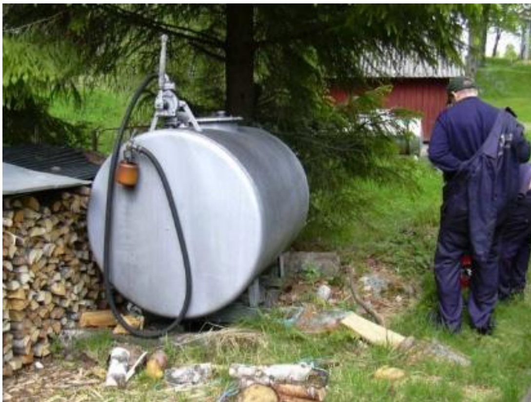
Cistern 1,5 m 3 i gott skick men olämpligt placerad Foto: Miljösamverkan Västra Götaland
