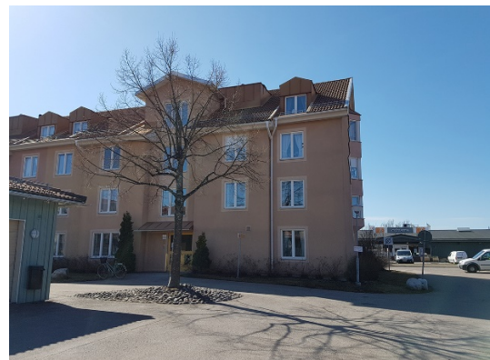
Bebyggelse inom Sims 12 sett västerut från fastighetens innergård.
