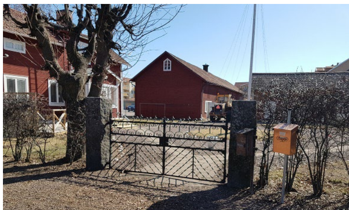
Dubbelgrind i smidesjärn och granitpelare.
