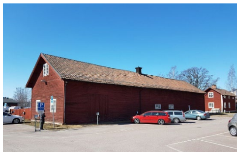
Den större ekonomibyggnaden som idag används som garage.
