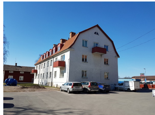
Byggnadens nordöstra och sydöstra fasad.
