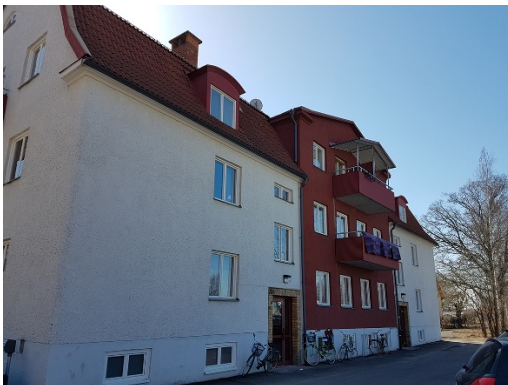
Byggnadens nordvästra fasad.
