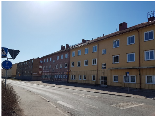
Bebyggelse längs med Bygatans västra sida sett från Tunagatan.
