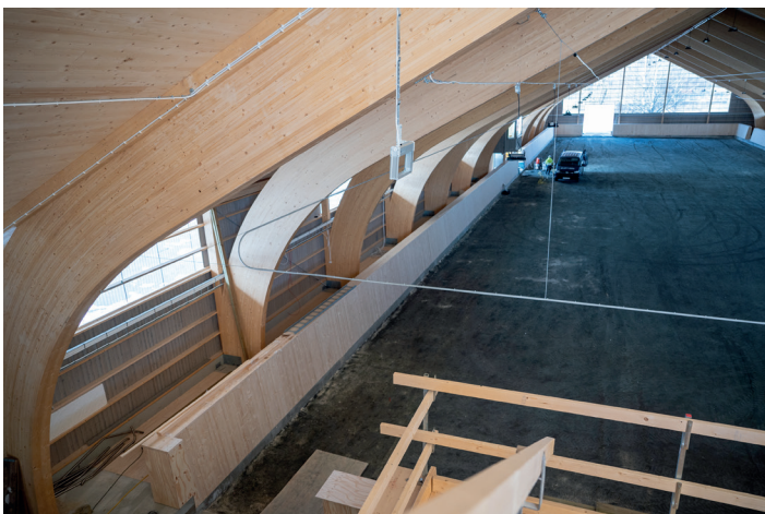
Gången bakom sargen i ridhus 1 har i det närmaste färdigställt. Det vita röret som syns i taket är bevattningsanläggningen.
