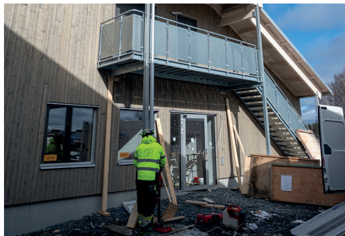
Den utvändiga trappen upp till läktaren är monterad.
