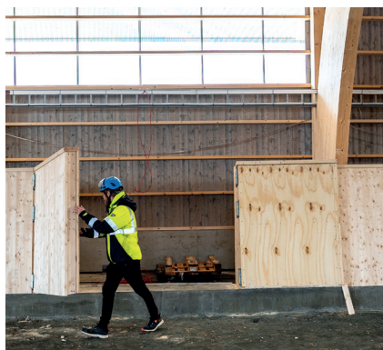
Sargen i ridhus 1 har fått rejäla dubbeldörrar.
