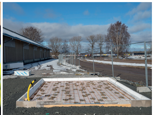
Här ska miljöhuset stå. Plattan gjuts under vecka 13.
