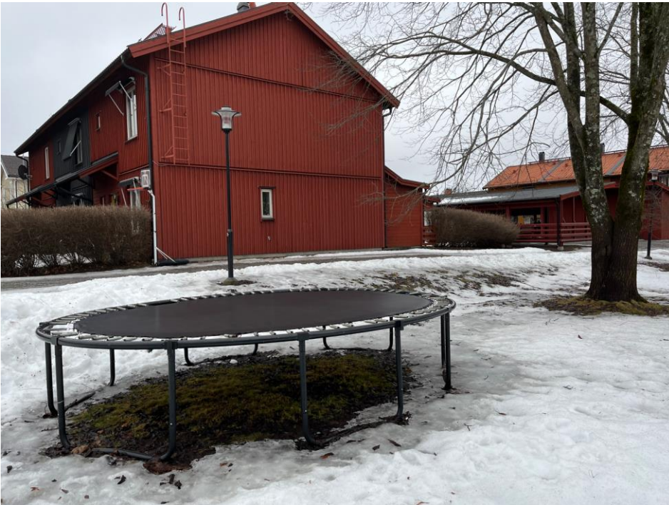
Figur 6. Befintliga byggnader väster om planerad byggnad (foto 2024-03-05).
