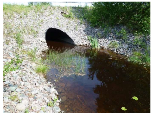
Figur 49. Trumman under landsvägen som förbinder sjön med Dalälven. Vattnet såg relativt klart ut vid besöket.
