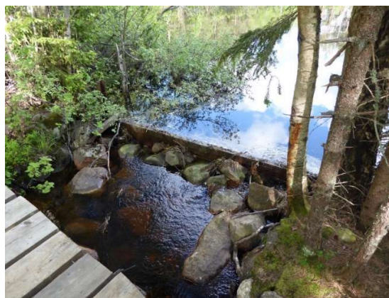
Figur 57. Dämnet läcker och behöver tätas.
