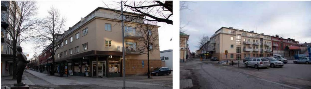
Figur 11. T.v. Centrumhuset mot Borganäsvägen med butiker mot gatan. T.h. Centrumhuset och Rixohuset mot gården med glasade trapphus. Foto: Kristoffer Ärnäck/Kulturmiljöanalys för kvarteret Balder, Dalarnas Museum.
