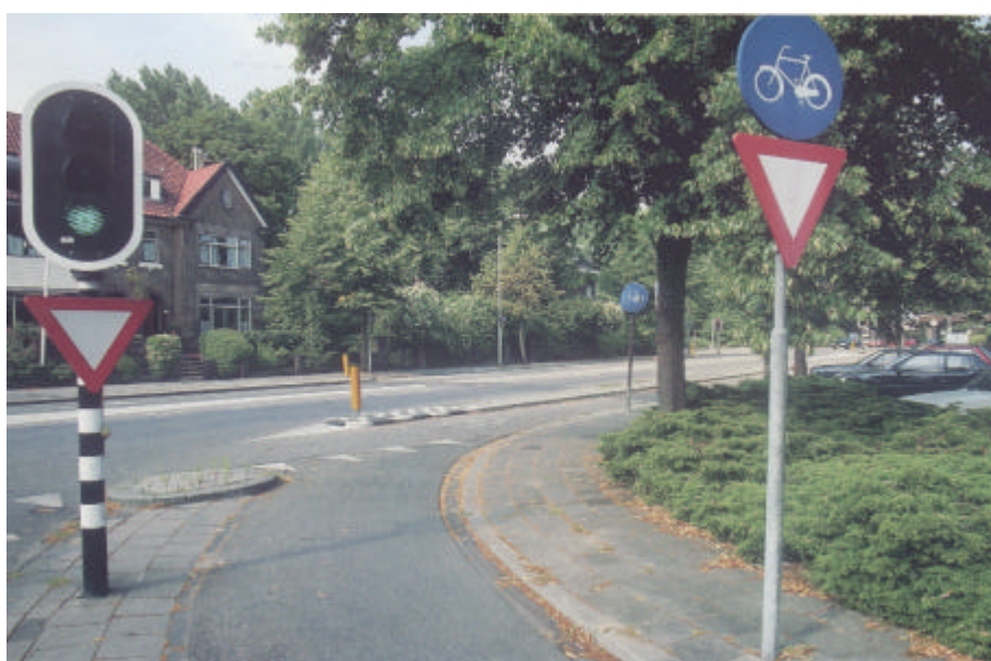
Bild 2: Från Delft i Holland ges ett exempel på högersvängande cykeltrafik som leds förbi en trafiksignal. Cykeltrafiken är dock reglerad med väjningsplikt innan cyklisten får svänga in på den korsande vägen. Källa: Planera för cykeln, Krister Spolander, NTF
