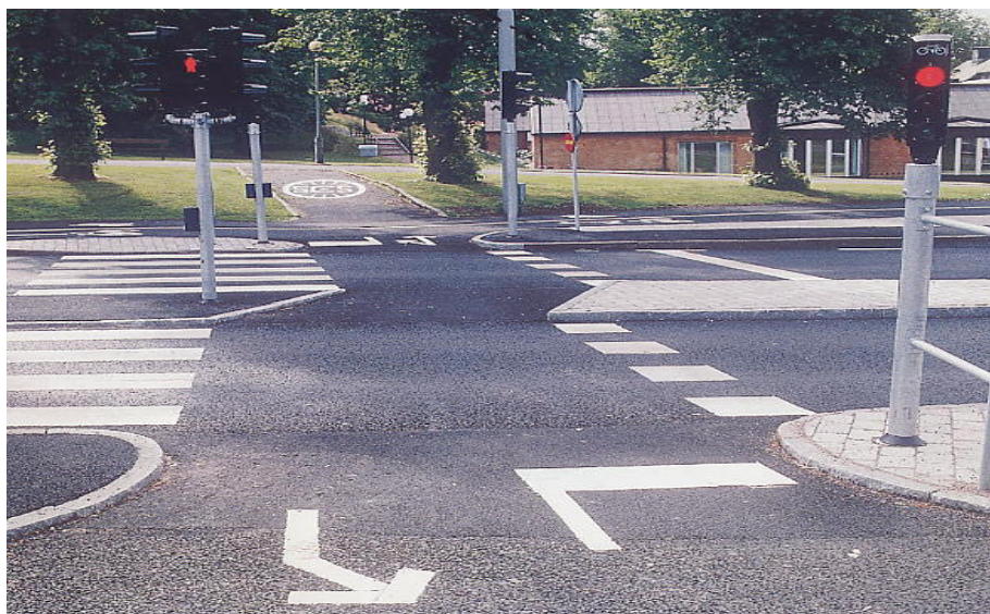
Bild 3: Överfarten är nedskuren genom refugen. Cyklisterna vinklar då kurs något under sin överfart och upptäcker då lättare motorfordon som är i ankommande. Idén förekommer också på övergångsställen. Åtgärden är bl. a. aktuell i punkt 21 på listan över korsningar. Källa: Planera för cykeln, K. Spolander, NTF.
