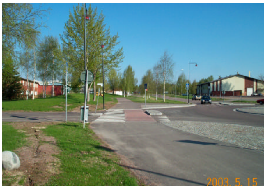
Bild 4: Överfart för cykel belagd med röd sten i kombination med ett övergångsställe. Exemplet är hämtat från området runt Teknikdalen i Borlänge.
