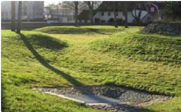
Figur 12. Exempel på torrdamm (multifunktionell yta) hämtad från Uppsala Vatten exempelsamling för dagvattenhantering.
