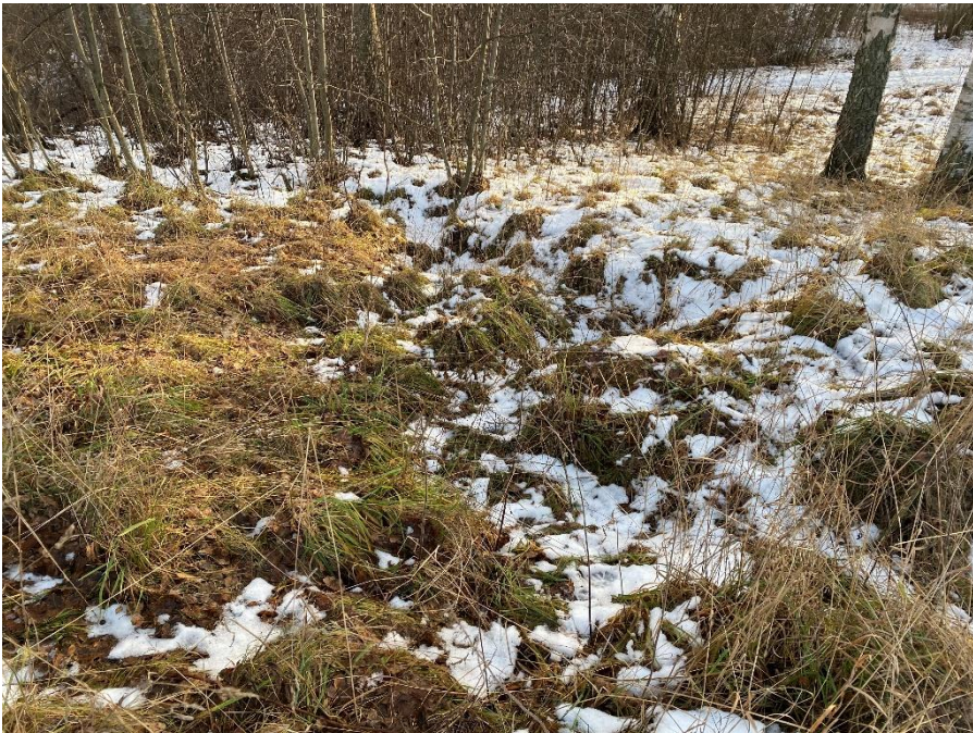
Figur 3 Svackor i mark vid släntkrön.
